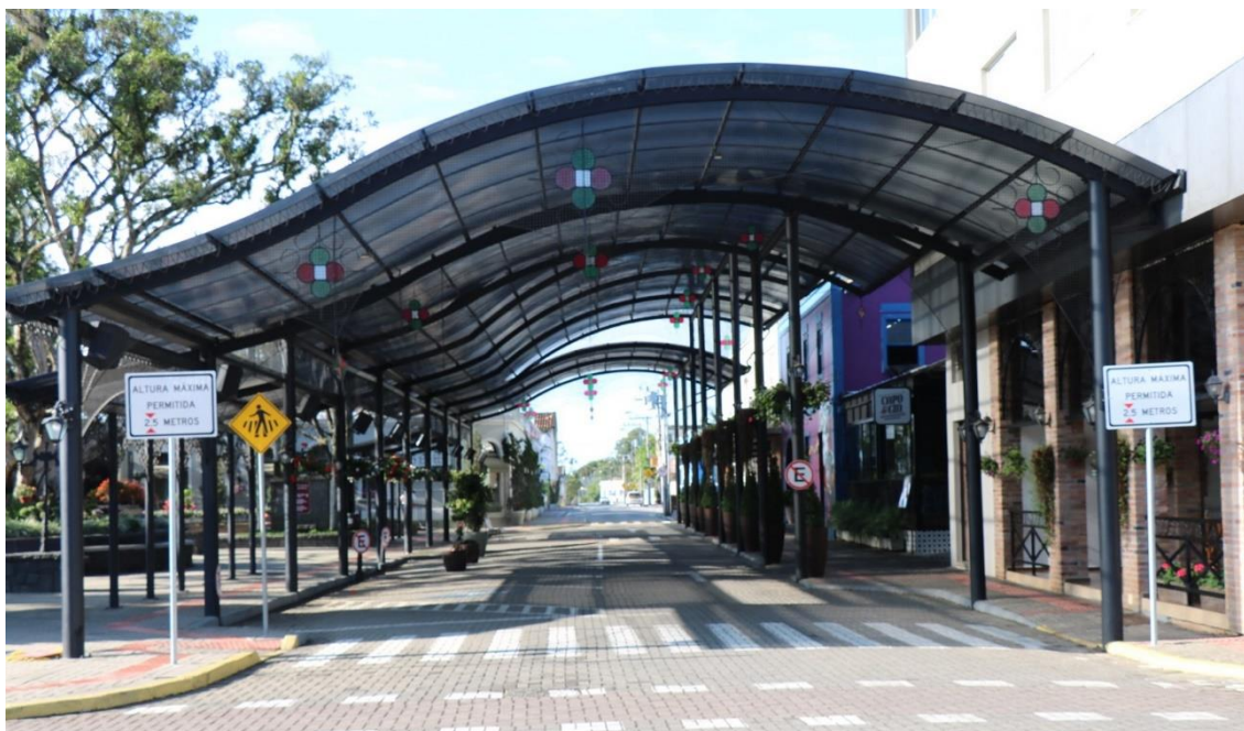
Figura 18 – Rua Coberta, no município de Nova Veneza/SC.
