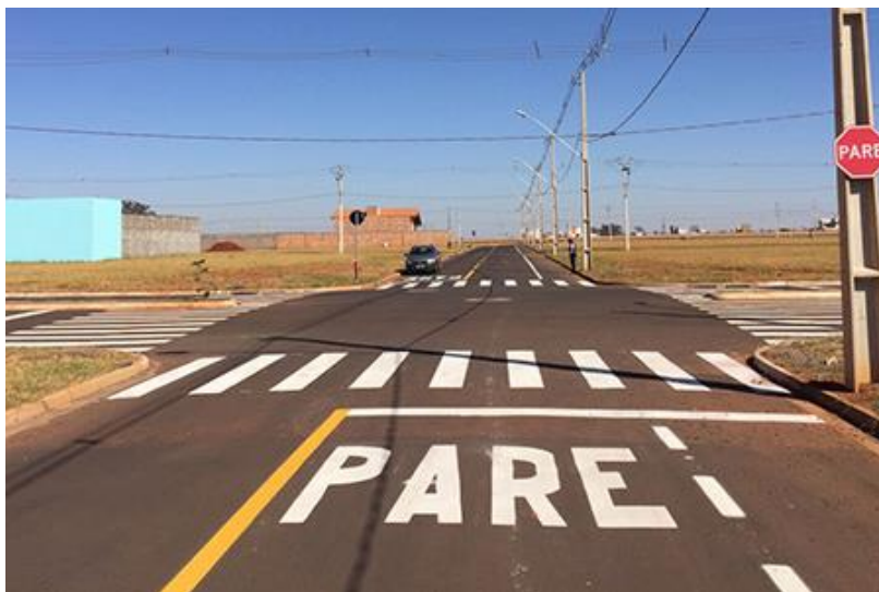
Figura 15 – Exemplo de Sinalização horizontal e vertical em atendimento ao CTB.
